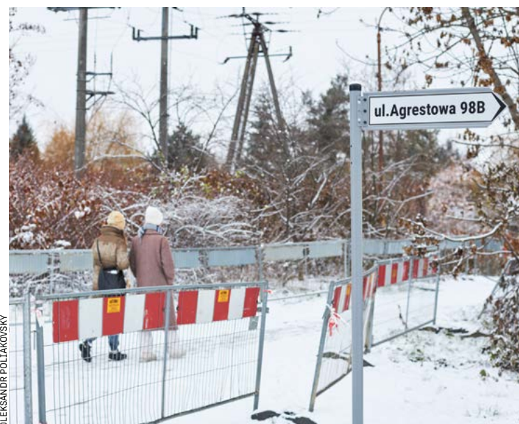
Prace rozpoczęły się 12 grudnia, nowa trasa będzie też oświetlona
