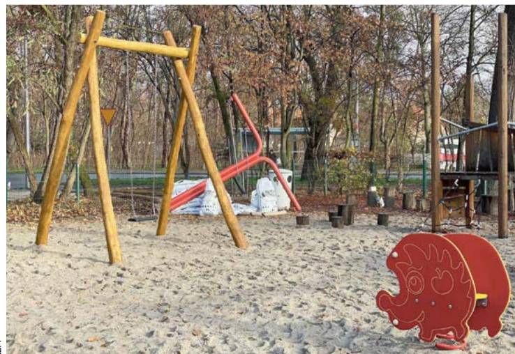
Na placu już zostały zamontowane nowe urządzenia do zabawy
