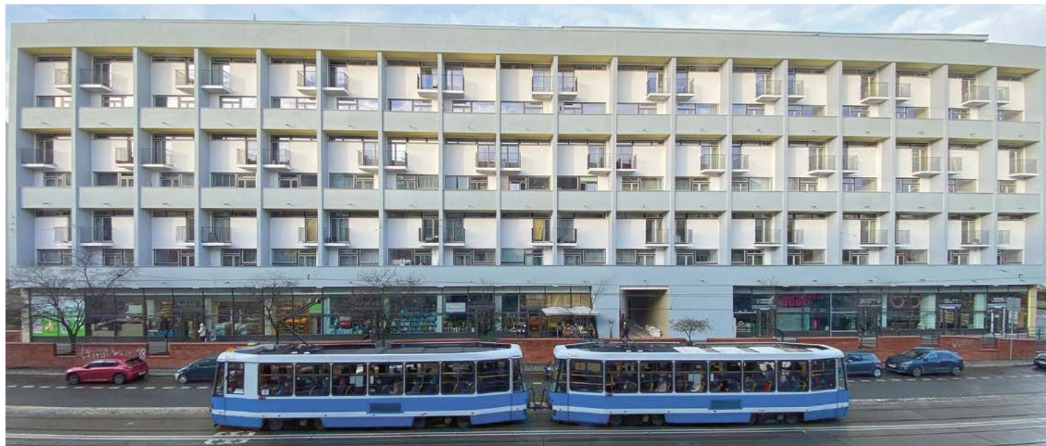
Projekt remontu budynku przygotowała pracownia VROA Architekci. Roboty ruszyły w 2020 roku i były podzielone na kilka etapów
